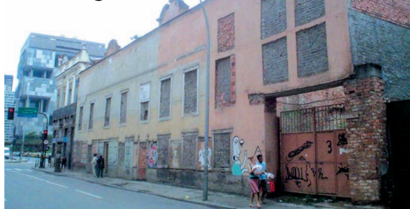
O Sinpol construiu toda fachada do prédio
